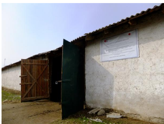
Склад для хранения оборудования Вывеска об успешном завершении проекта на таджикском и английском языках
